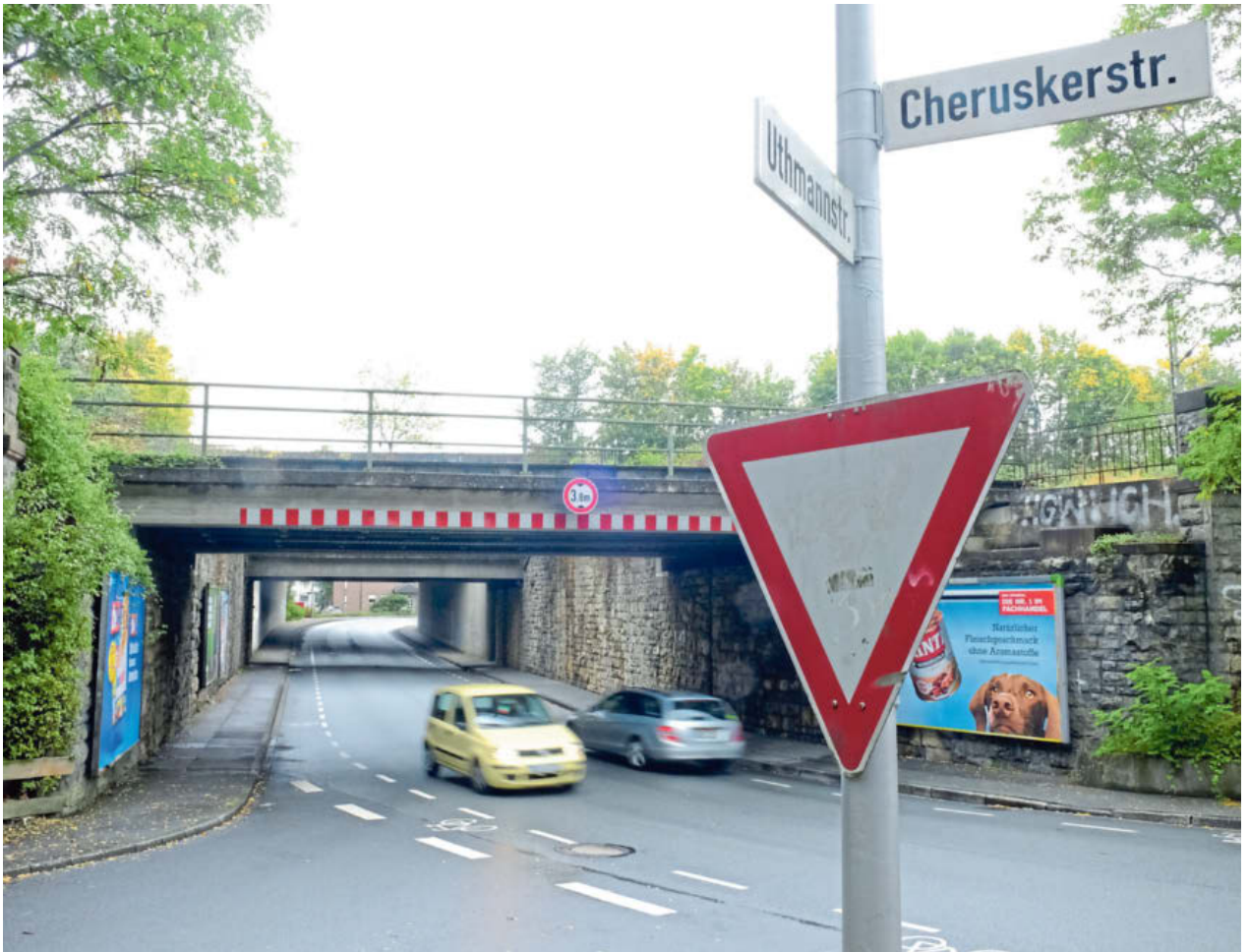
Eisenbahnunterführung Cheruskerstraße: Die Wohngebiete links und rechts der Bahnstrecke werden zukünftig durch zwei bis drei Meter hohe Schutzwände vor dem Bahnlärm besser geschützt. Auch an anderer Stelle wird gebaut.
