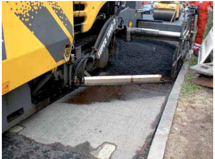
Bild 6: Einbau einer DSH-V, Quelle: Asphaltta
