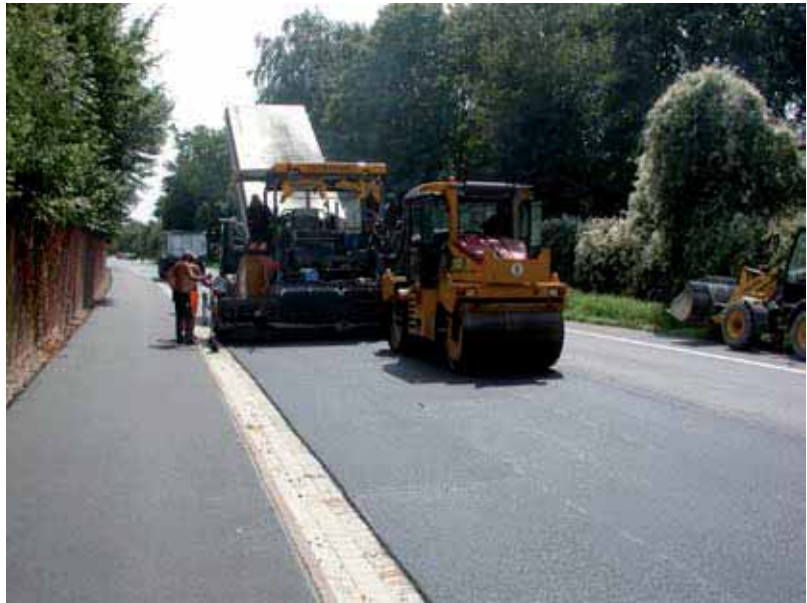
Bild 7: Einbau eines LOAD auf der B474 in Coesfeld
