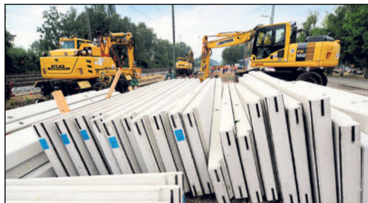
Etwa 1,2 Tonnen schwer sind die Betonelemente, die am Sockel der Lärmschutzwand montiert werden.
